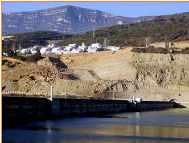
Deslizamiento ladera izquierda en el embalse de Yesa (Navarra)
