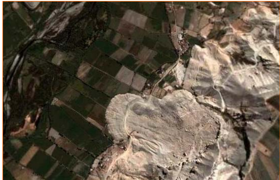
Vista aérea deslizamiento Pie de Cuesta en Arequipa (Perú)
