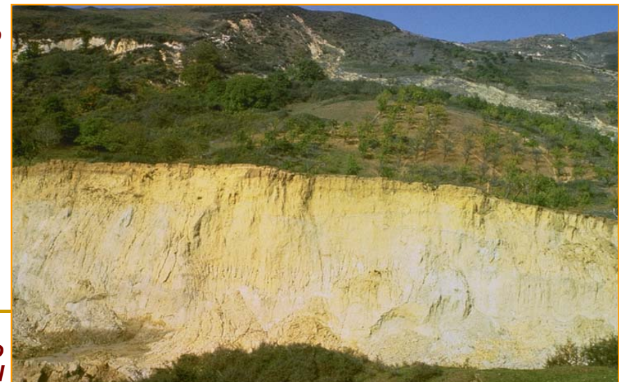
Deslizamiento traslacional dormido
